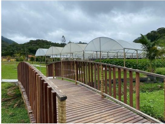
Figura 9. Estrutura de ponte na Heckert Flores.
