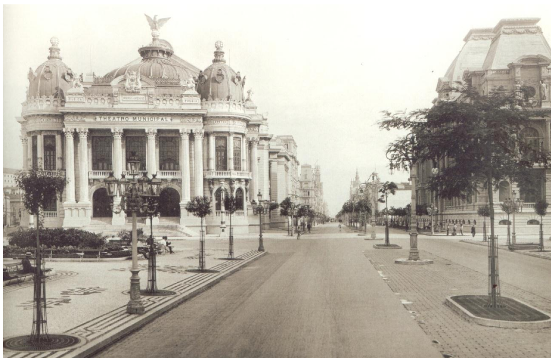
Figura 3: O Theatro Municipal e Avenida Central em 1910 – Praticamente todos os elementos construtivos que aparecem na fotografia são de rochas. Fonte: Marc Ferrez (1910).
